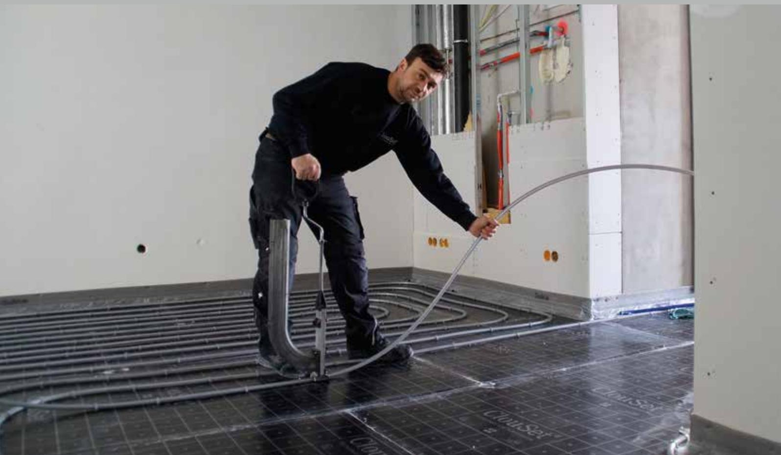
Verlegung Systemrohr auf Tackerplatte
